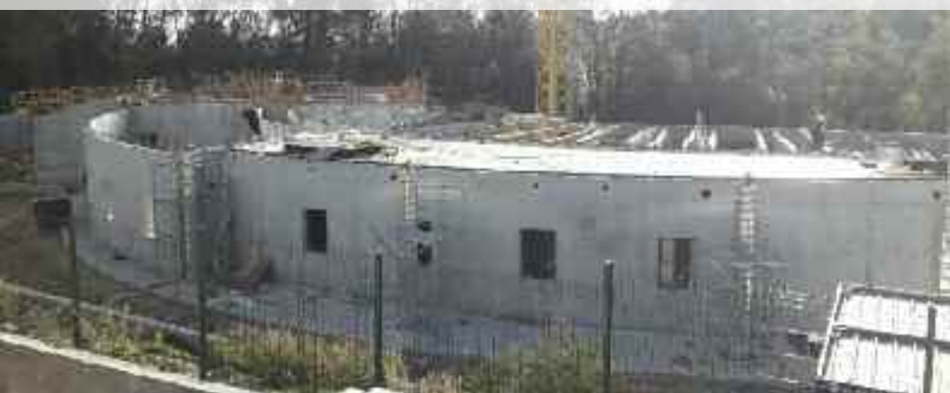
Poursuite des travaux du Centre de Secours
