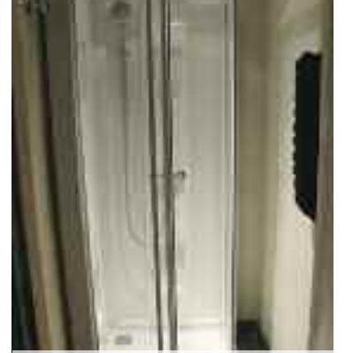
Création d'une douche Pôle image
