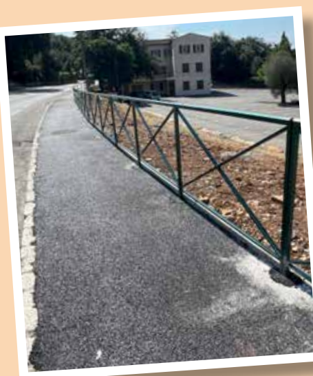
Refection du trottoir et pose de garde-corps.
