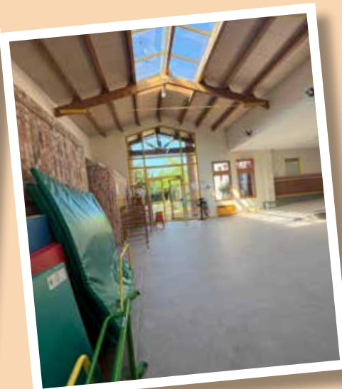
Refection du sol (hall et cuisine) de l'école maternelle Layet Boutonnier.
